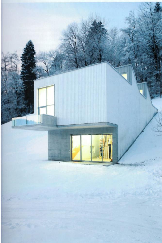
**Die Beleuchtung funktioniert in der Tiefe des Raums vor allem über die Fenster im Scheddach, also eigentlich einer Fabrikdachform, die aber schon lange auch für Ateliers verwendet wird.**
