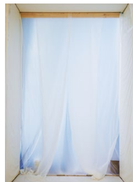
Der Farbstaub setzt sich überall ab, daher muss die gesamte Umgebung mit Plane abgeklebt werden.
